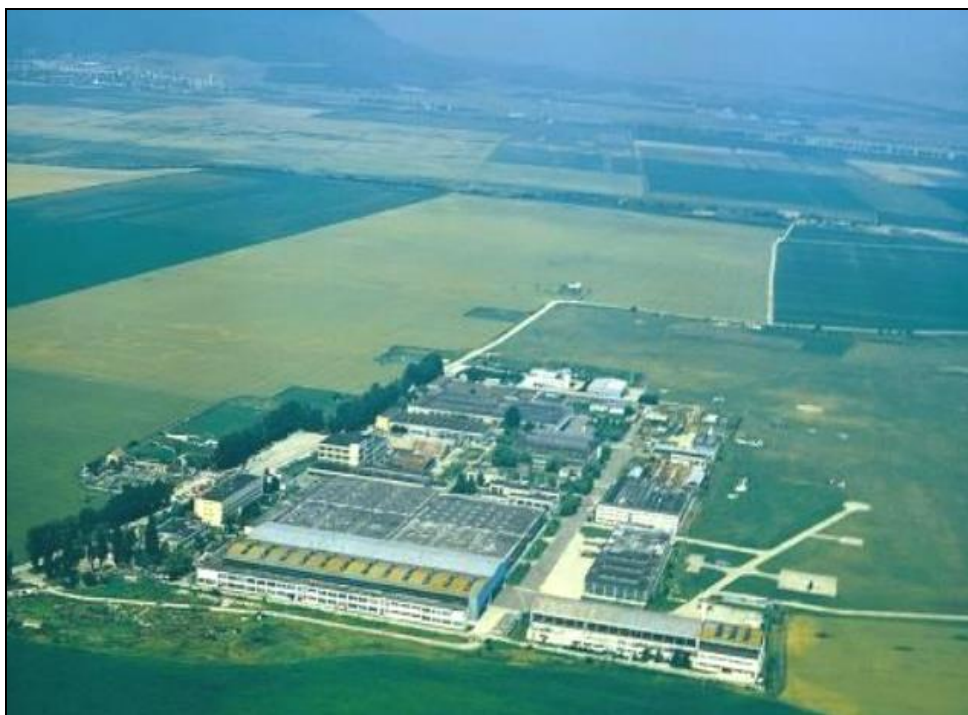
Vedere aeriană ICA Ghimbav – Brașov
